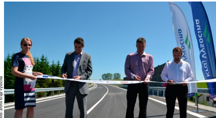
Kraj Vysočina v létě 2014 zprůjezdil obchvat obce Jamné. Náměstek hejtmana pro dopravu Libor Joukl úsek dlouhý 1,76 km otevřel krátce před prázdninami. Celkové náklady stavby se vyšplhaly na 156 milionů korun.
