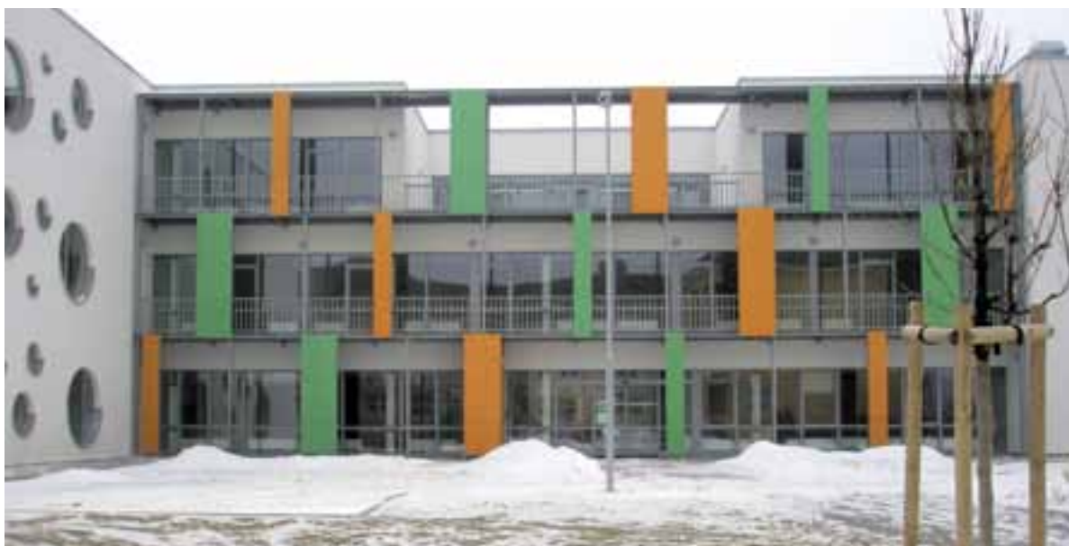
Domov pro seniory ve Velkém Meziříčí stavěl kraj Vysočina rok a půl. Celkové náklady ve výši 123 milionů korun z části zaplatí ze státní dotace.
