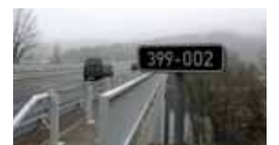
Opravu Stropěšinského mostu zaplatil kraj Vysočina z ROP Jihovýchod.
