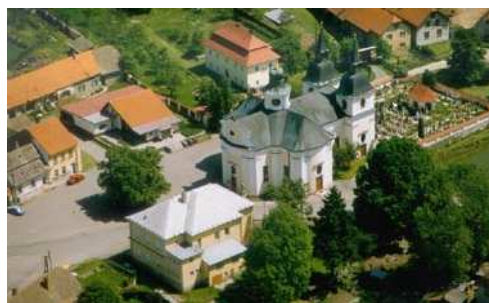
Fig. 4 Historické centrum Zvole tvoří komplex budov navržený architektem J. B. Santinim s dominantou kostela sv. Václava.
