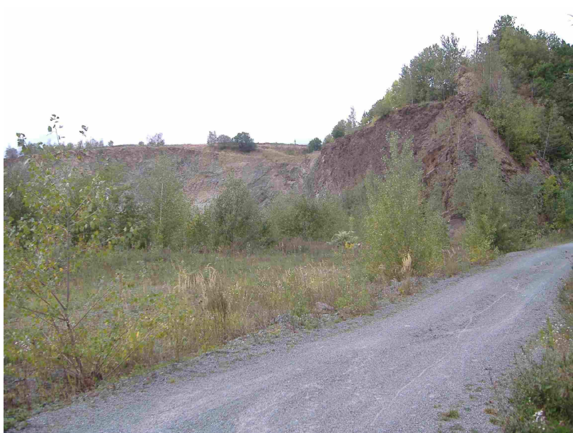
DSCF1428.JPG – pohled z cesty vedoucí podél řeky směrem k jámě skryté za stromky vlevo. Cesta tvoří protipovodňovou hráz bránící zaplavení lomové jámy.
