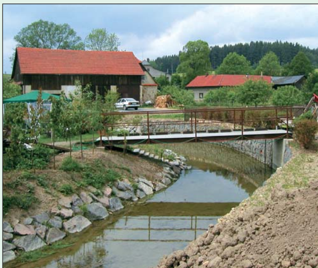
Úprava Třebovky v Opatově
