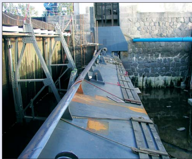
Oprava hradící konstrukce na jezu Čelákovice na Labi
