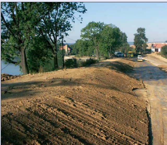
Rekonstrukce hráze rybníka Hvězda na Třebovce
