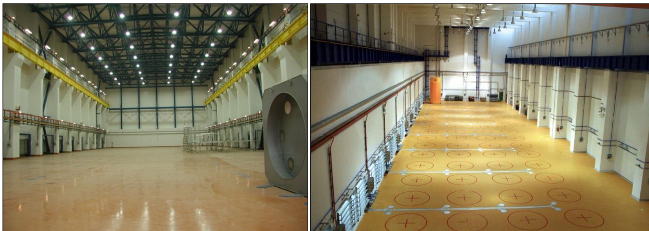
Obrázek vlevo: Mezisklad vyhořelého jaderného paliva Jaderné elektrárny Dukovany (zdroj: www.cez.cz )
