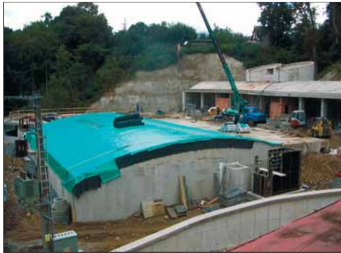
Cílý stavební ruch na čistírně v Náměšti nad Oslavou. Foto: archiv kraje
