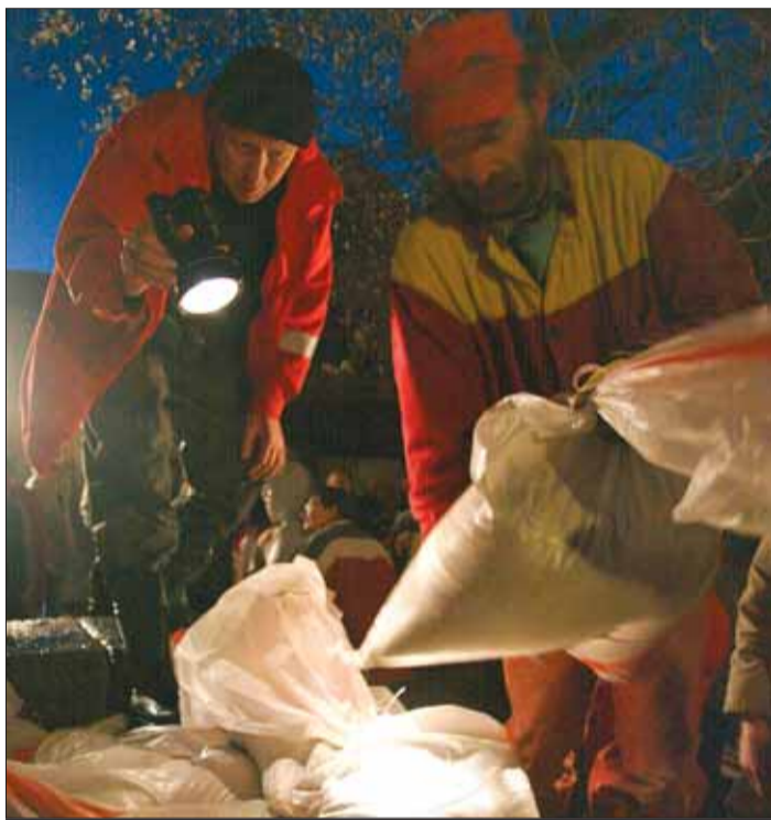
Noční stavění hrází z pytlů. Celý týden, každou noc, stále dokola. Foto: Luboš Pavlíček
