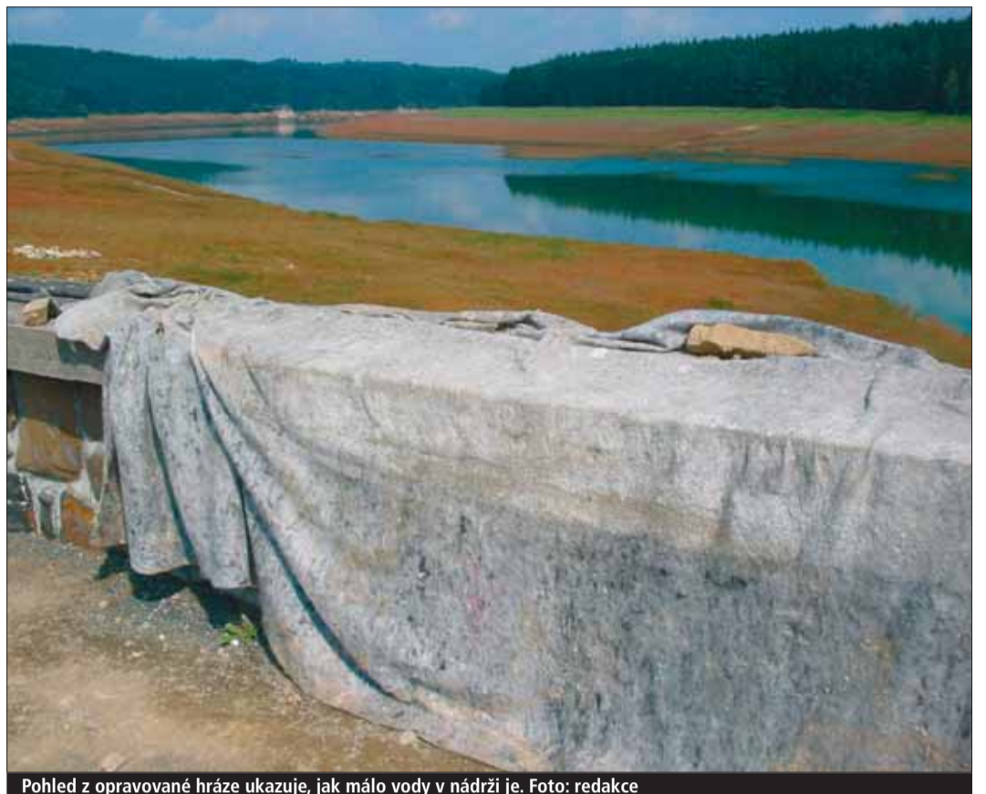
Pohled z opravované hráze ukazuje, jak málo vody v nádrži je. Foto: redakce
