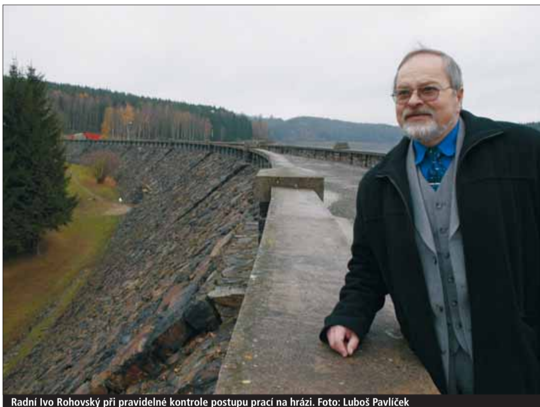
Radní Ivo Rohovský při pravidelné kontrole postupu prací na hrázi. Foto: Luboš Pavlíček
