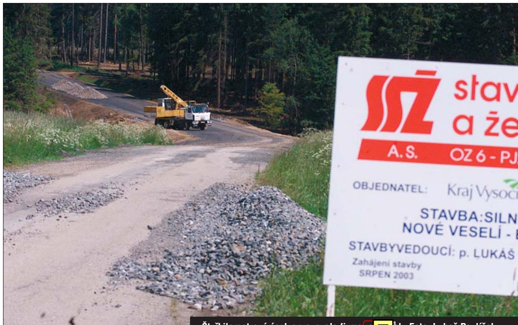
Čtyřkilometrový úsek opravovala firma ro...pk. Foto: Luboš Pavlíček
