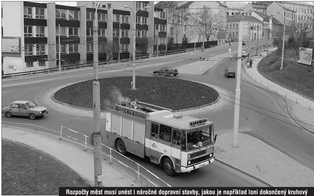
Rozpočty měst musí unést i náročné dopravní stavby, jakou je například loni dokončený kruhový objezd v Jihlavě. Foto: Luboš Pavlíček
