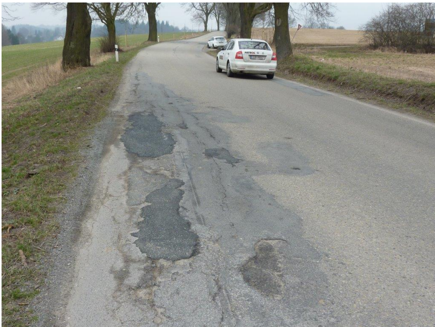
Stávající stav ešené silnice II/523
