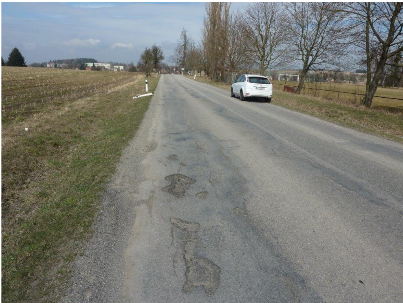
Stávající stav ešené silnice II/523
