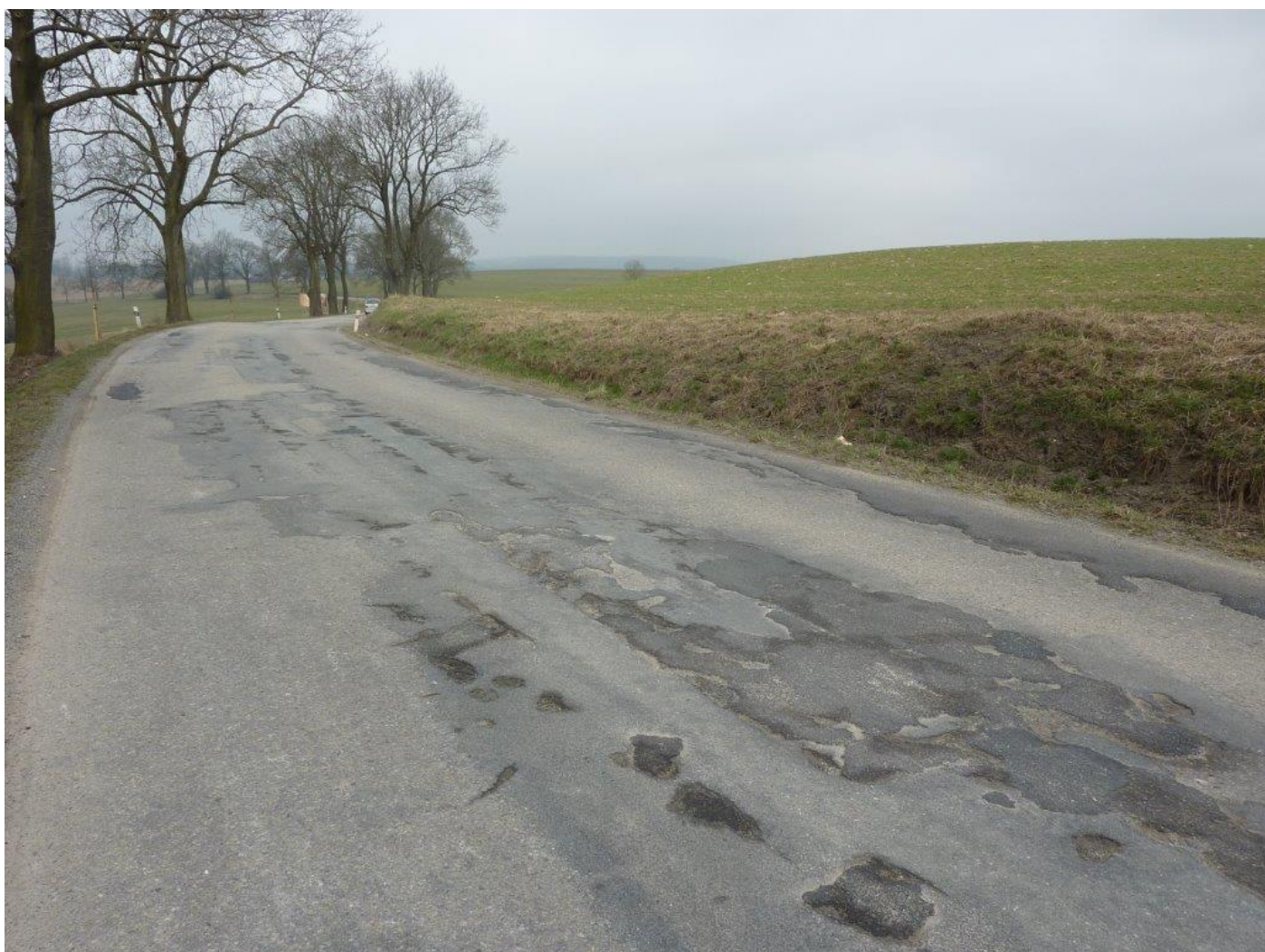
Stávající stav řešené silnice II/523
