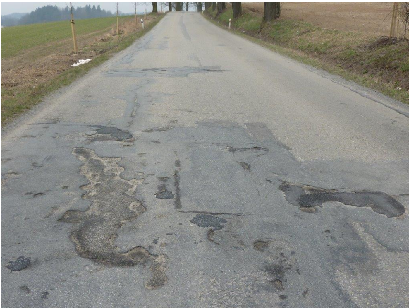
Stávající stav ešené silnice II/523
