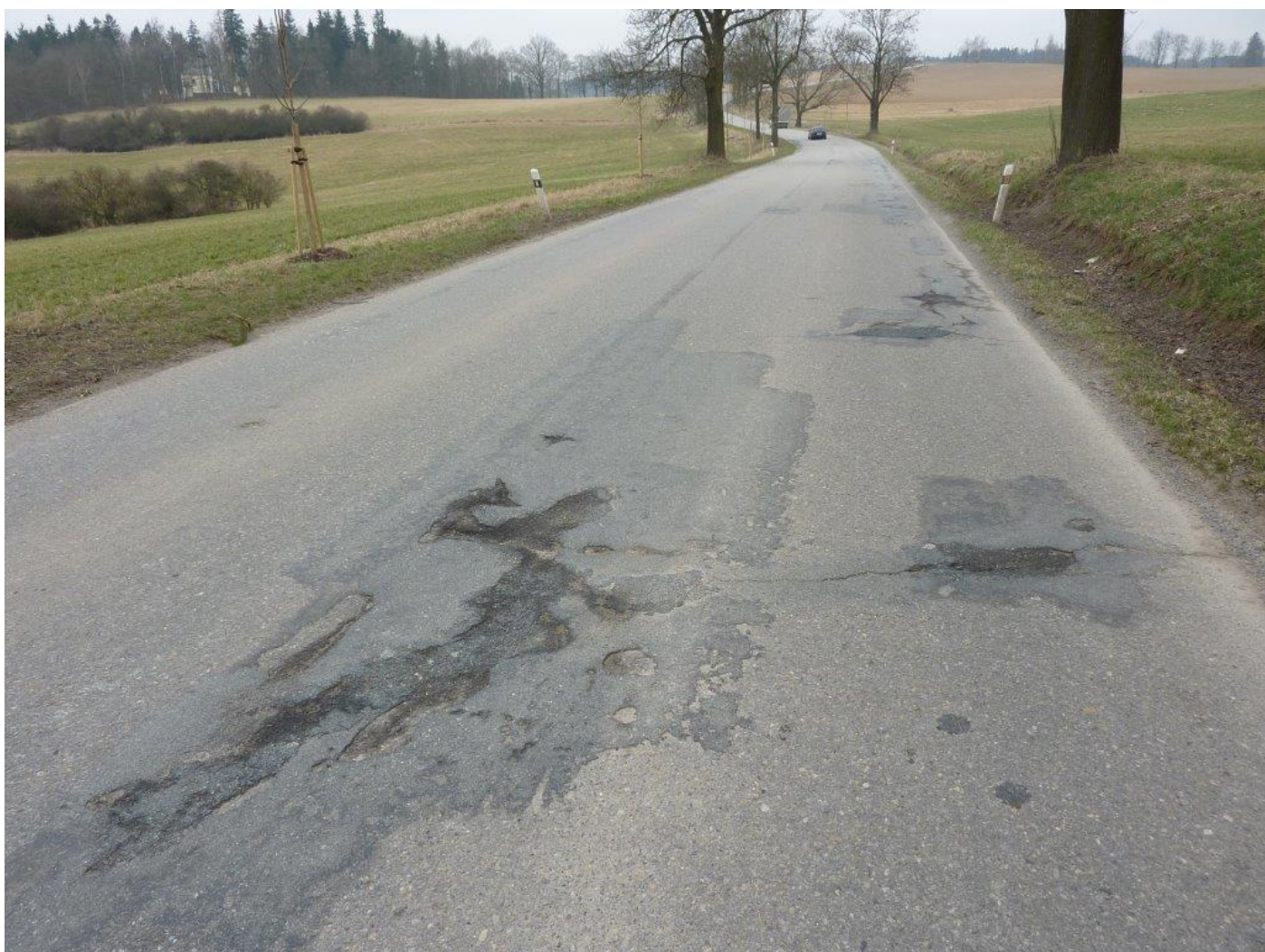
Stávající stav ešené silnice II/523
