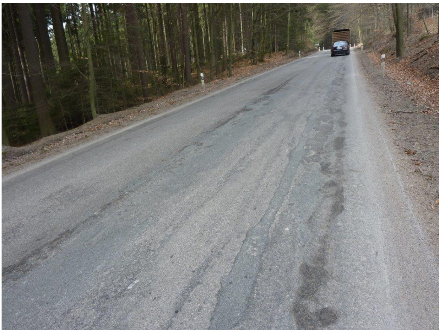
Stávající stav řešené silnice II/523
