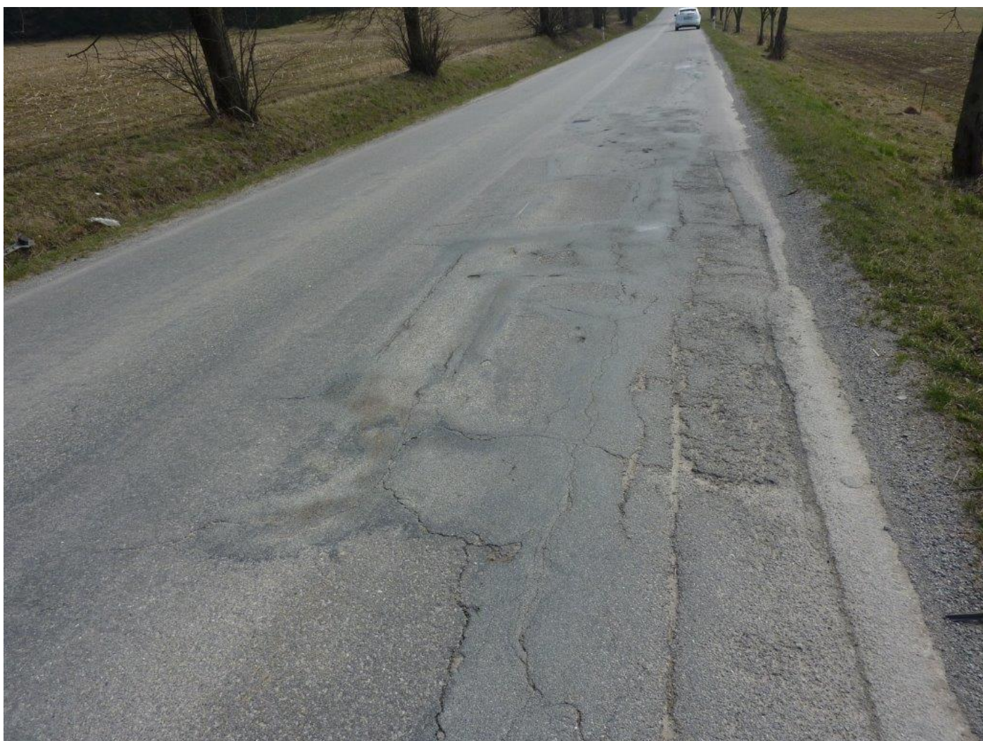
Stávající stav ešené silnice II/523
