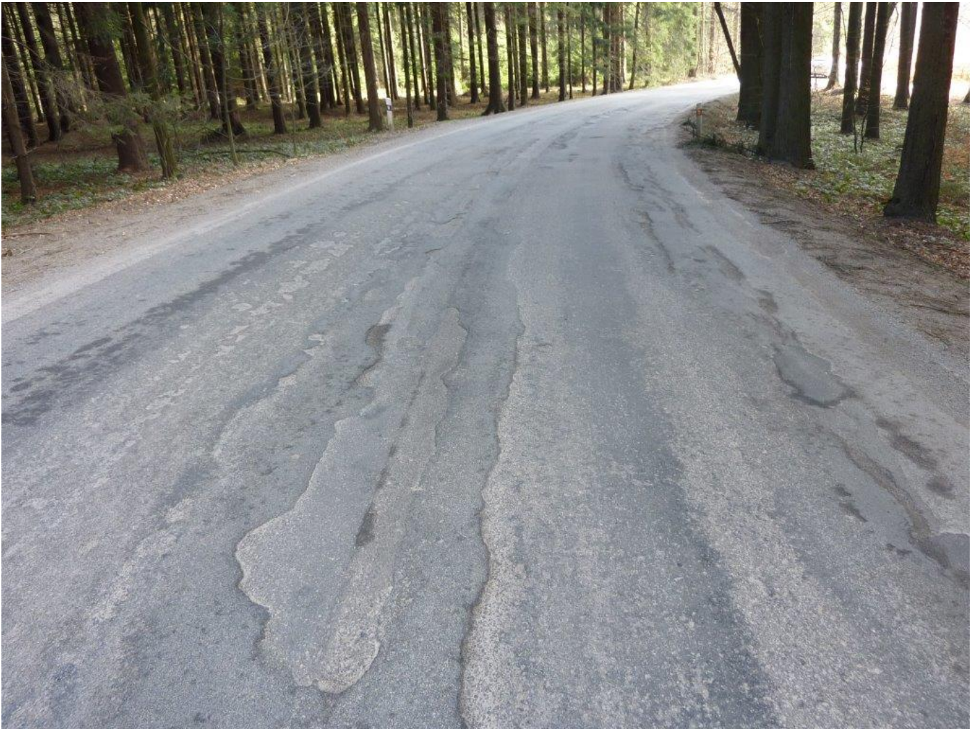
Stávající stav ešené silnice II/523
