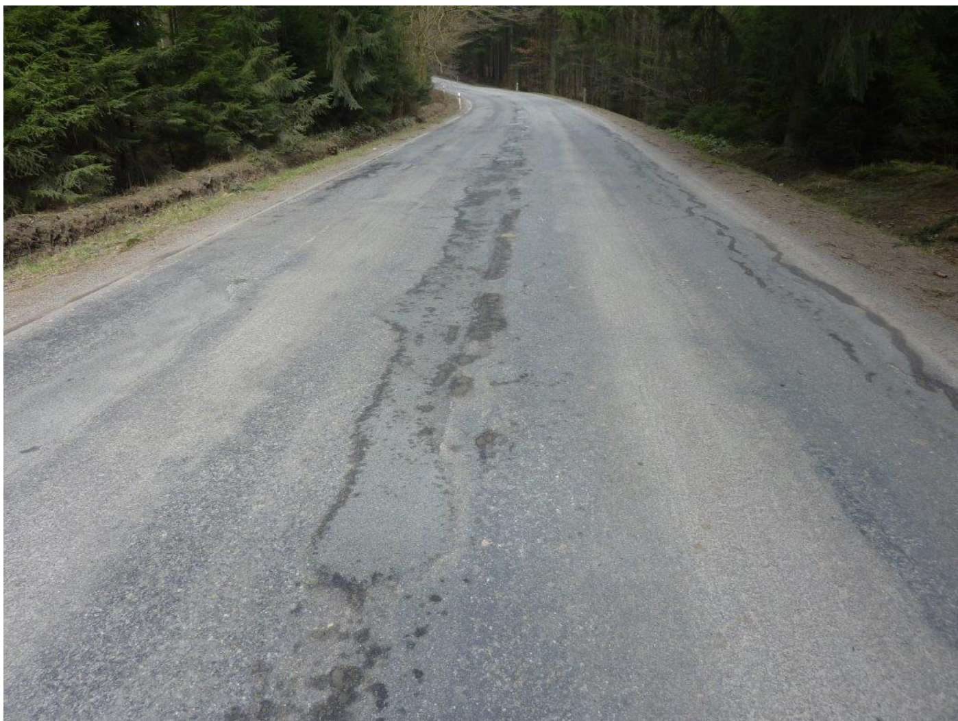
Stávající stav ešené silnice II/523
