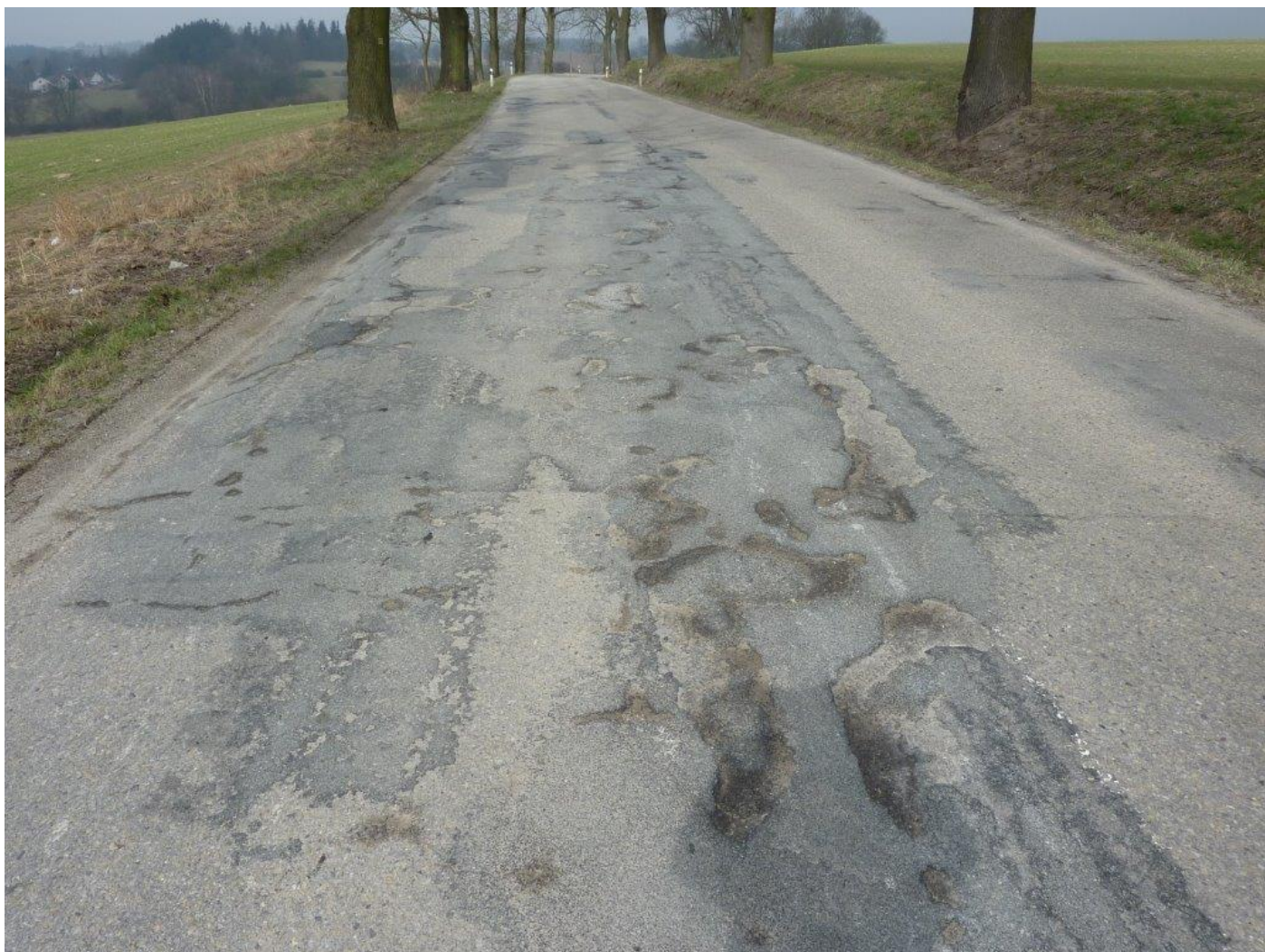
Stávající stav ešené silnice II/523
