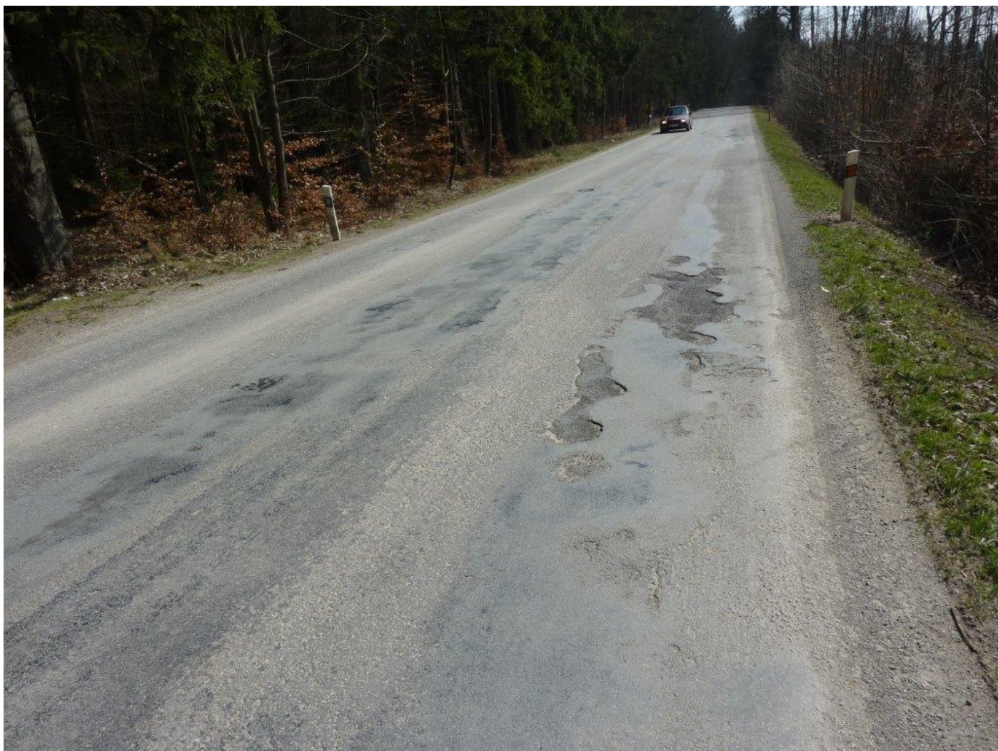
Stávající stav ešené silnice II/523
