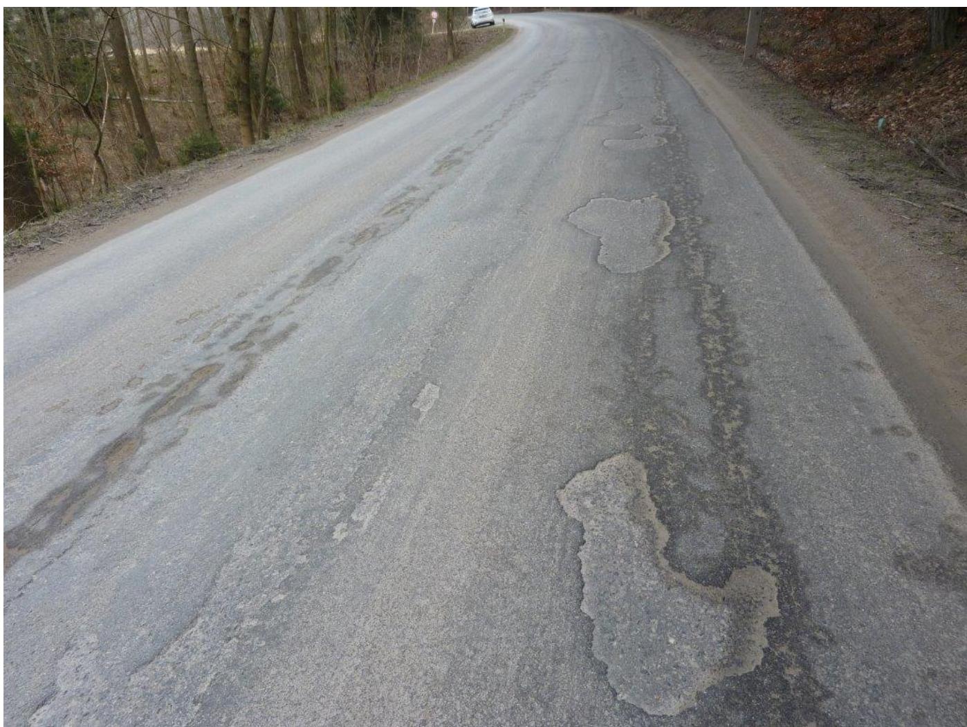
Stávající stav ešené silnice II/523
