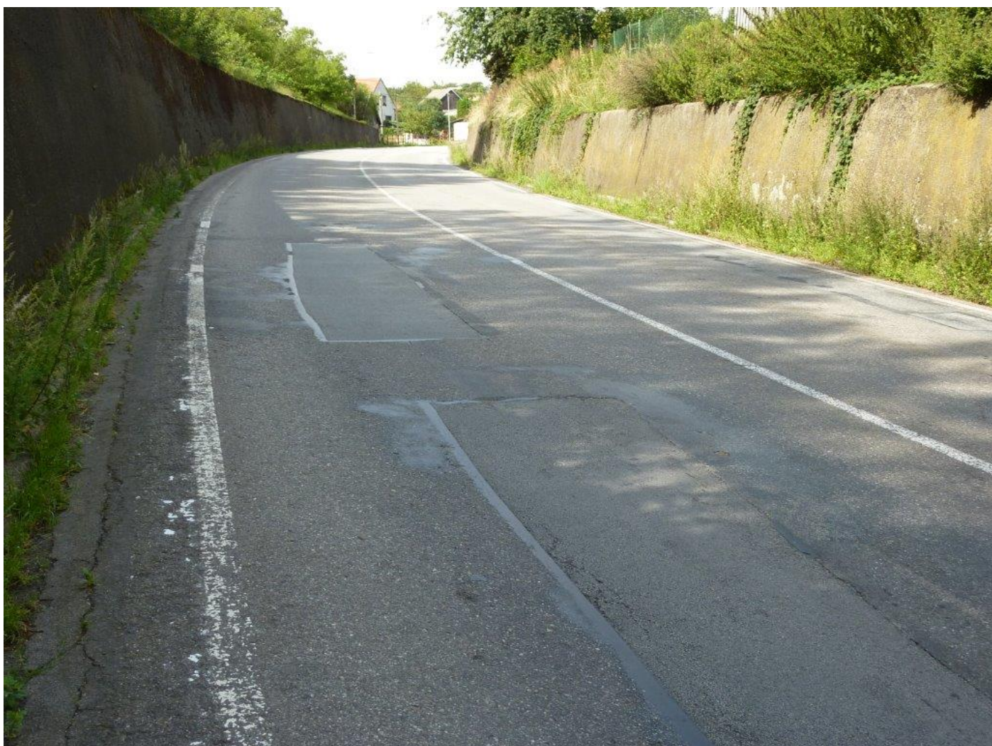
Stávající stav - 6. část (intraviláného ov) - opravné zdi
