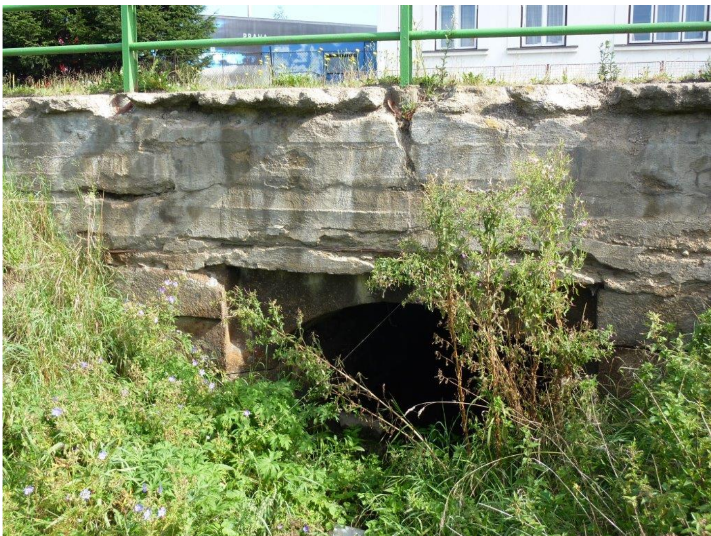
Stávající stav propustku - 4. část (intravilán M ín)
