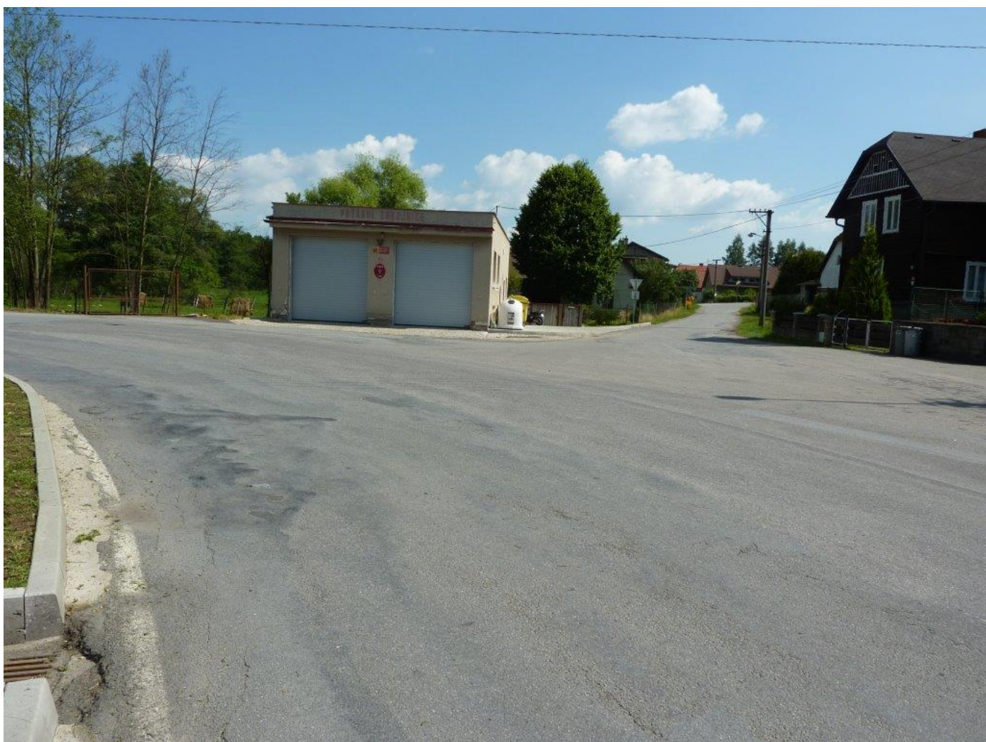
Stávající stav v obci Kejžlice - křižovatka s městem Krásná Hora - III/34765
