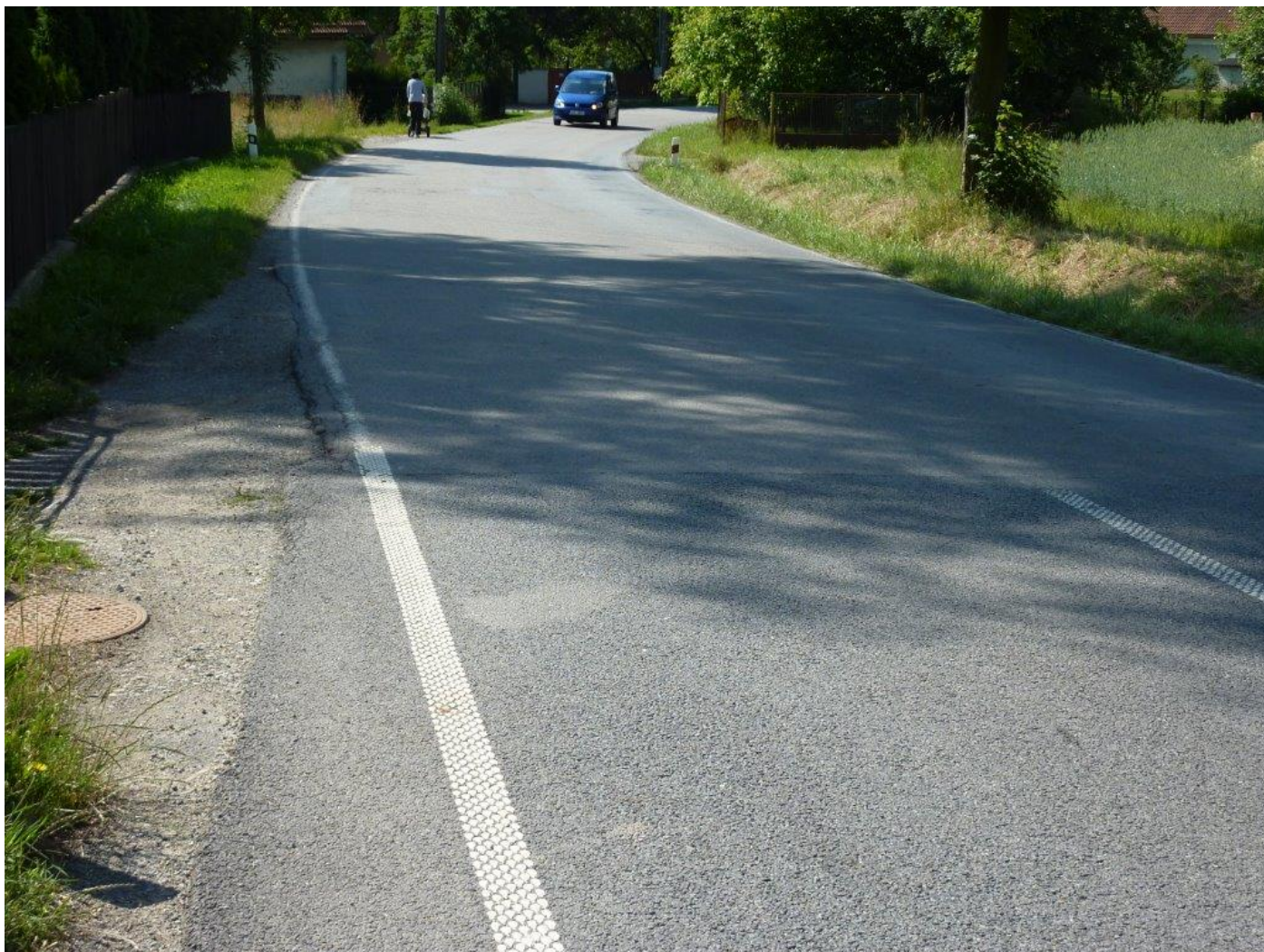
Stávající stav - na začátku řešeného úseku - v obci Keždice
