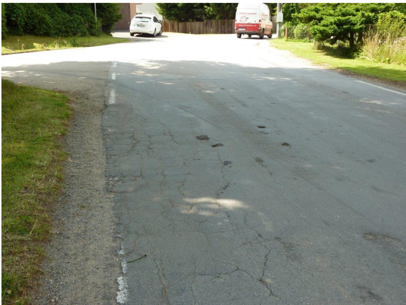
Stávající stav - na konci ešeného úseku - v obci ejov
