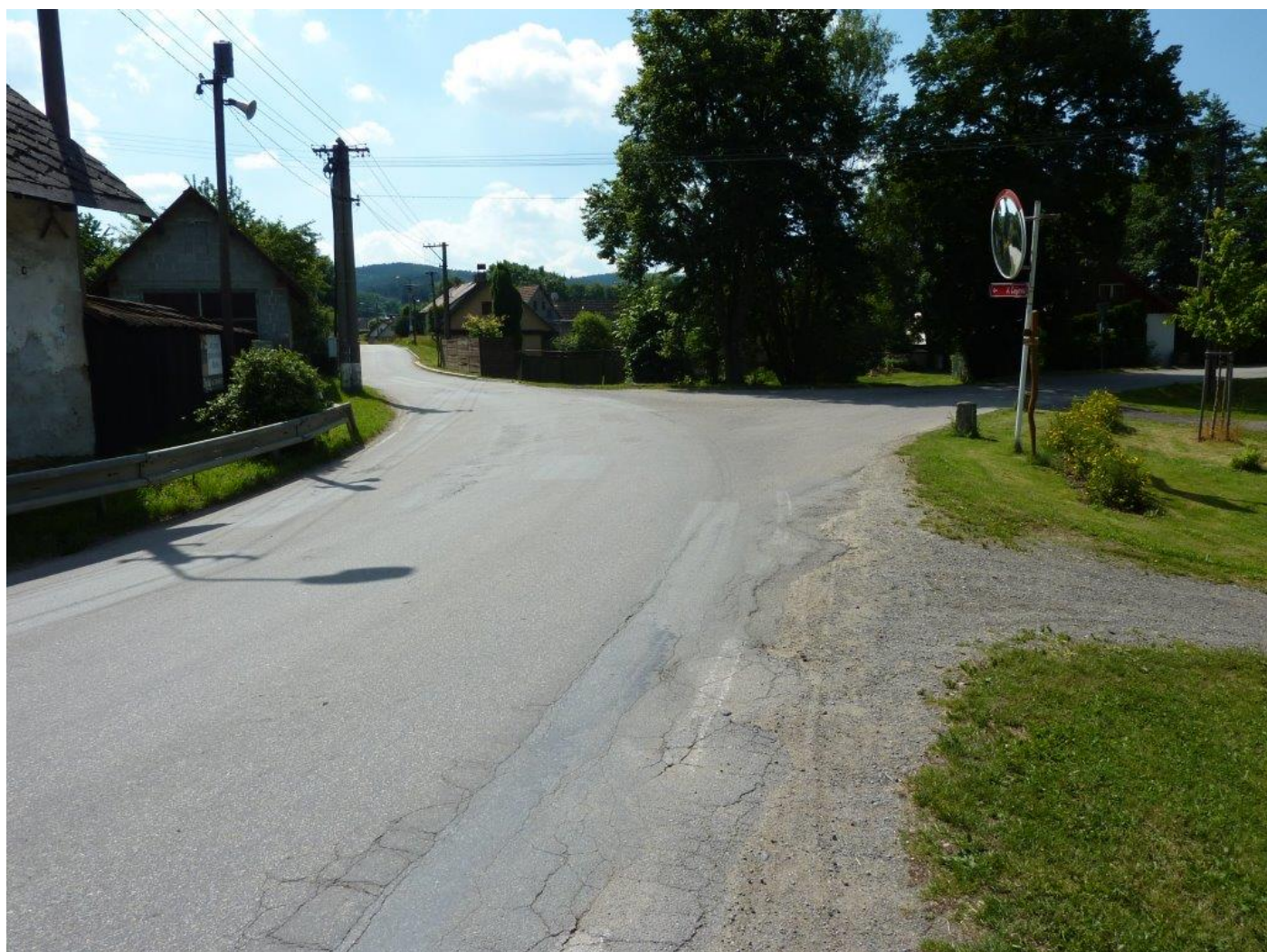
Stávající stav v obci Kežlice - křižovatka směrem Budíkov - III/34771
