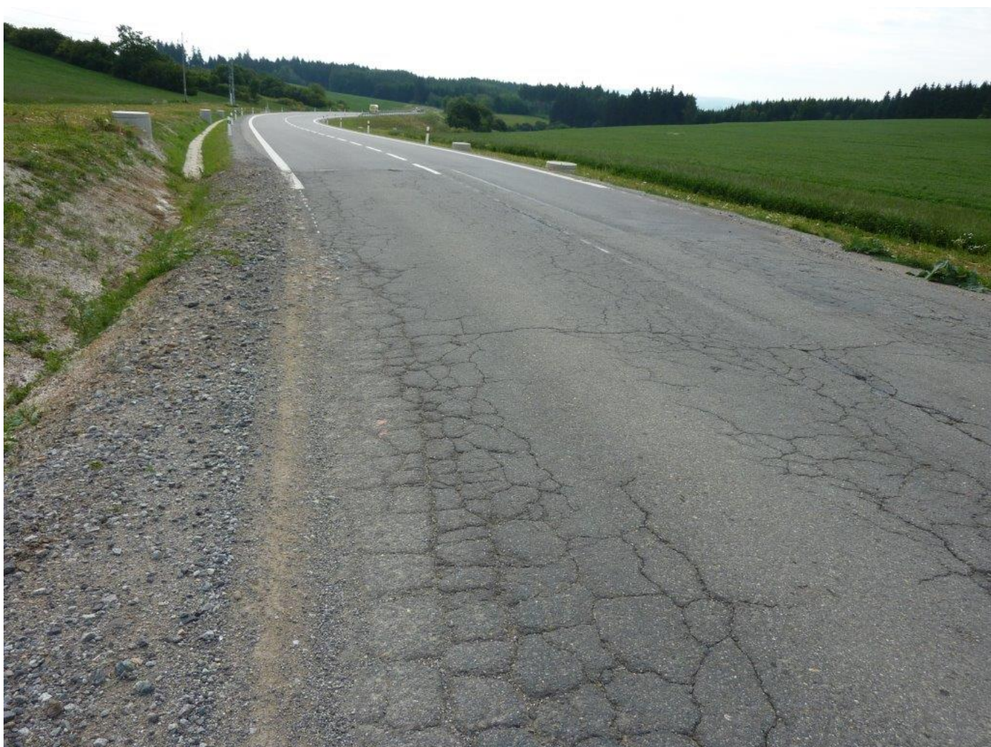
Stávající stav - na konci ešeného úseku - za obcí Zašovice
