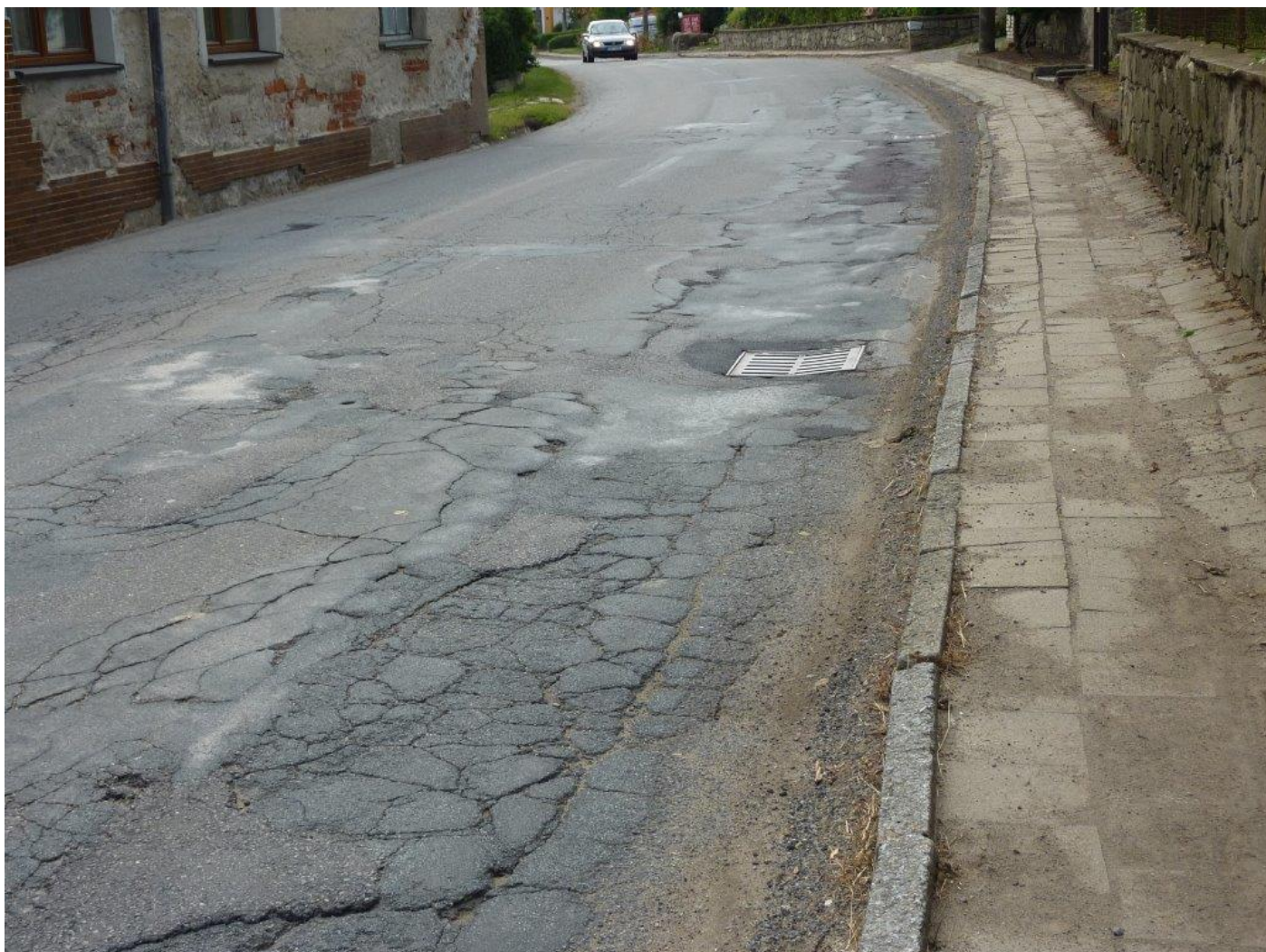
Stávající stav - v obci Zašovice
