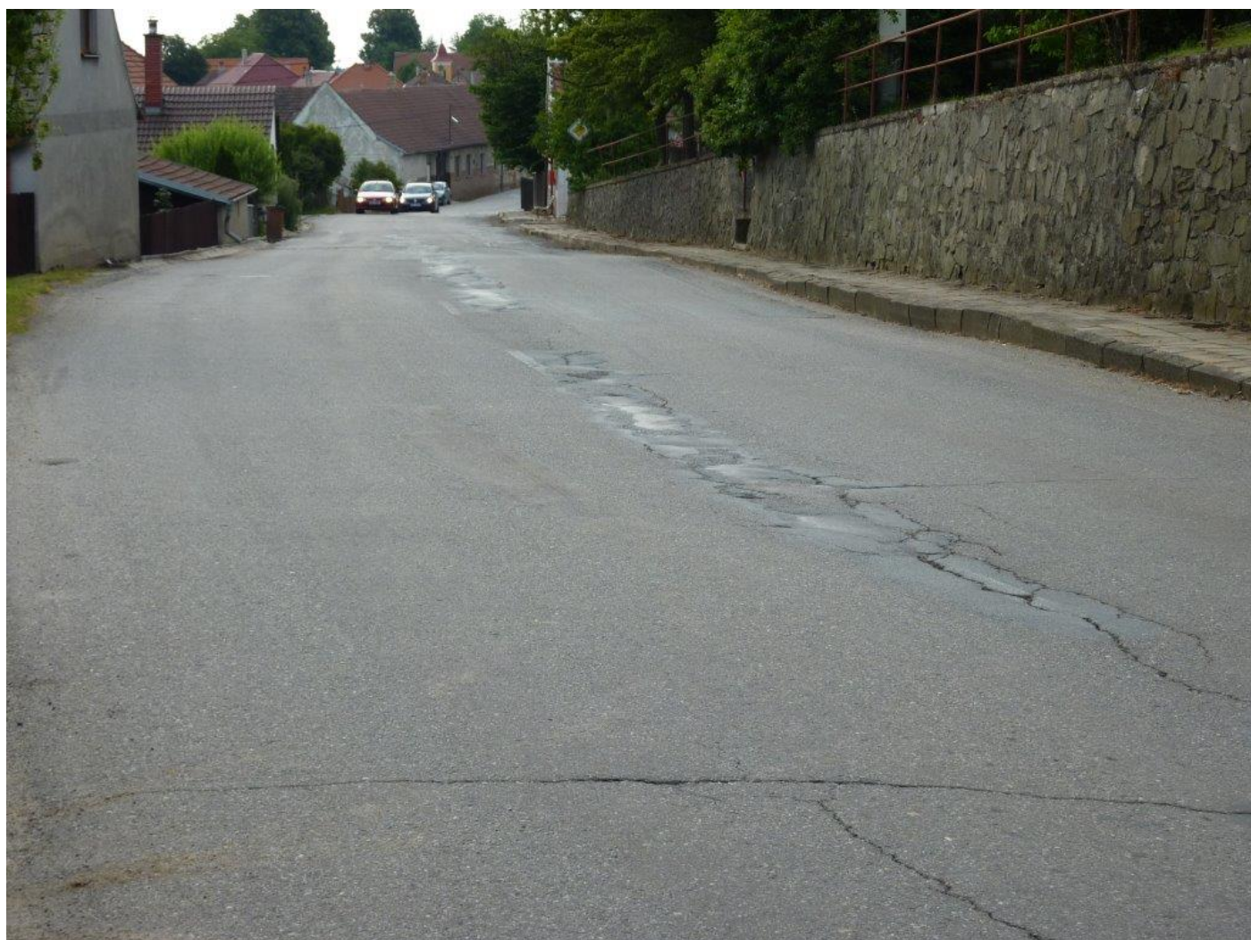
Stávající stav - v obci Zašovice
