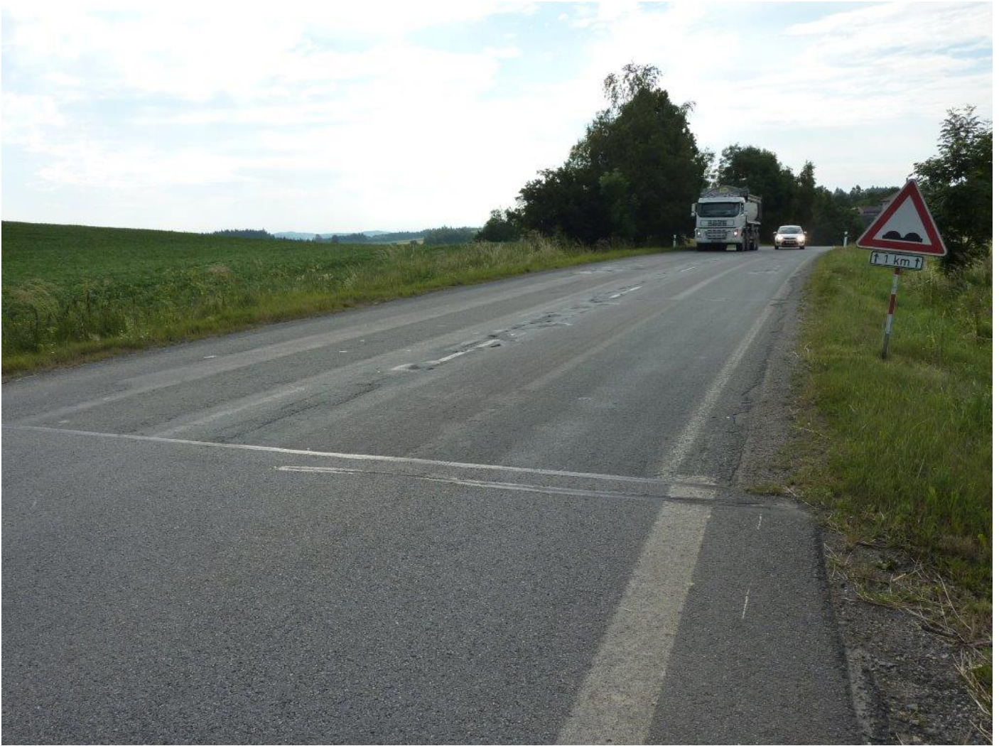
Stávající stav - na za átku ešeného úseku - p ed obcí Zašovice
