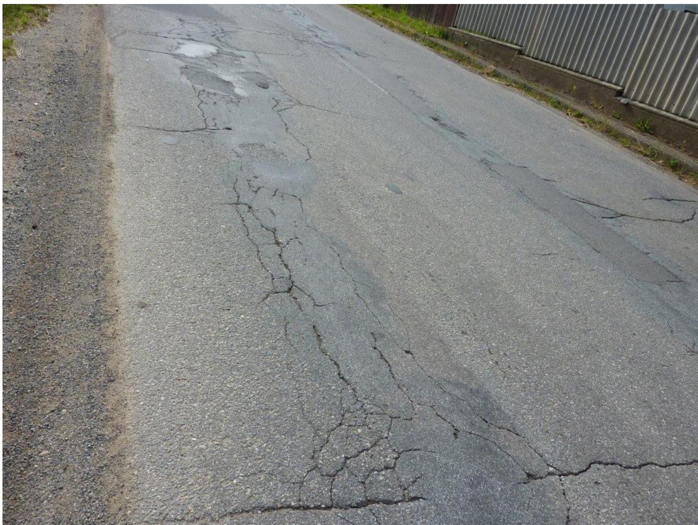
Stávající stav - v obci Zašovice
