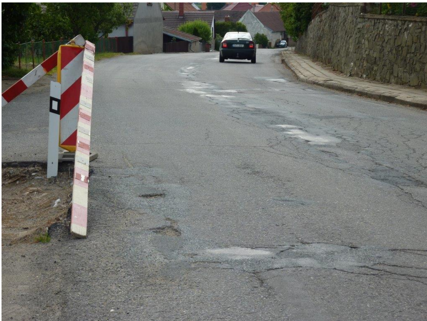
Stávající stav - v obci Zašovice
