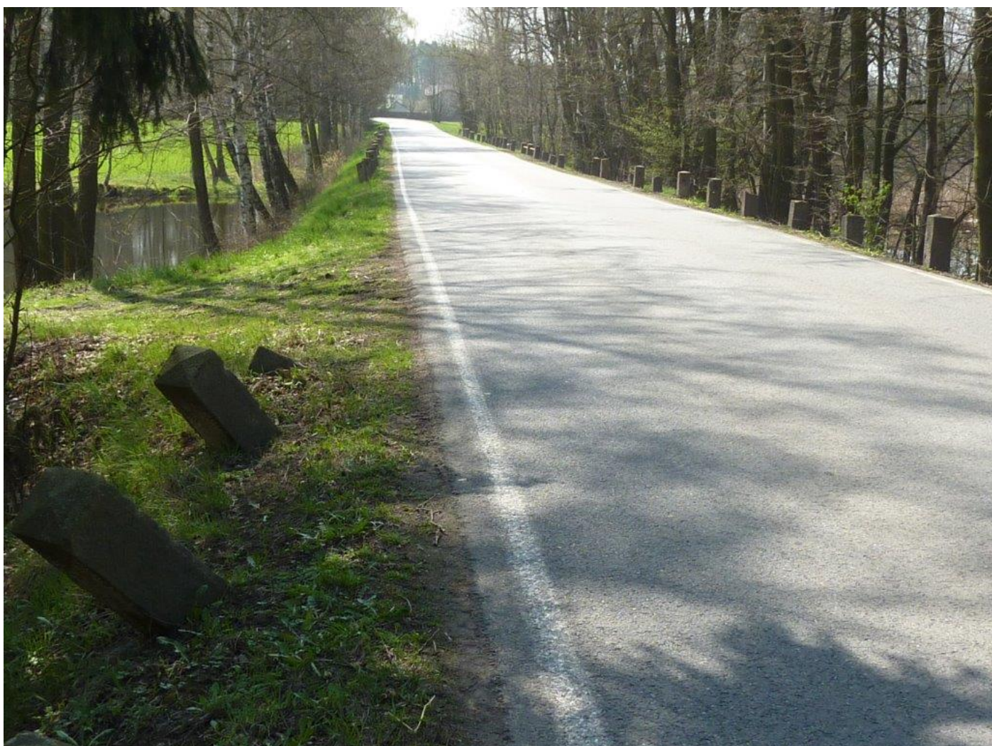
Stávající stav - hráz Radostovického rybníka - zejména nedostatečné šířkové uspořádání, nevhodné betonové patníky
