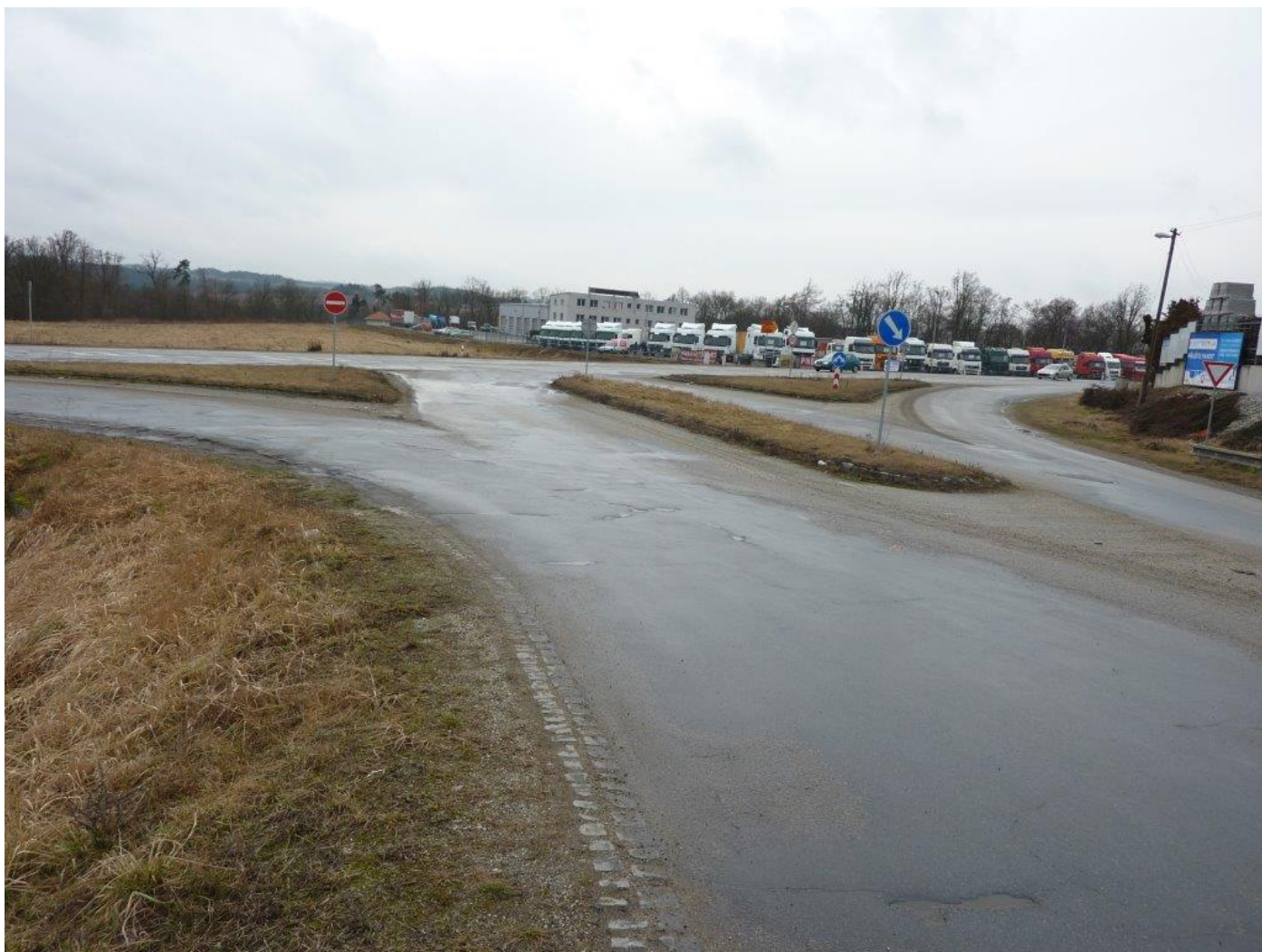
Stávající stav projektem řešeného území (budoucí okružní křižovatka)
