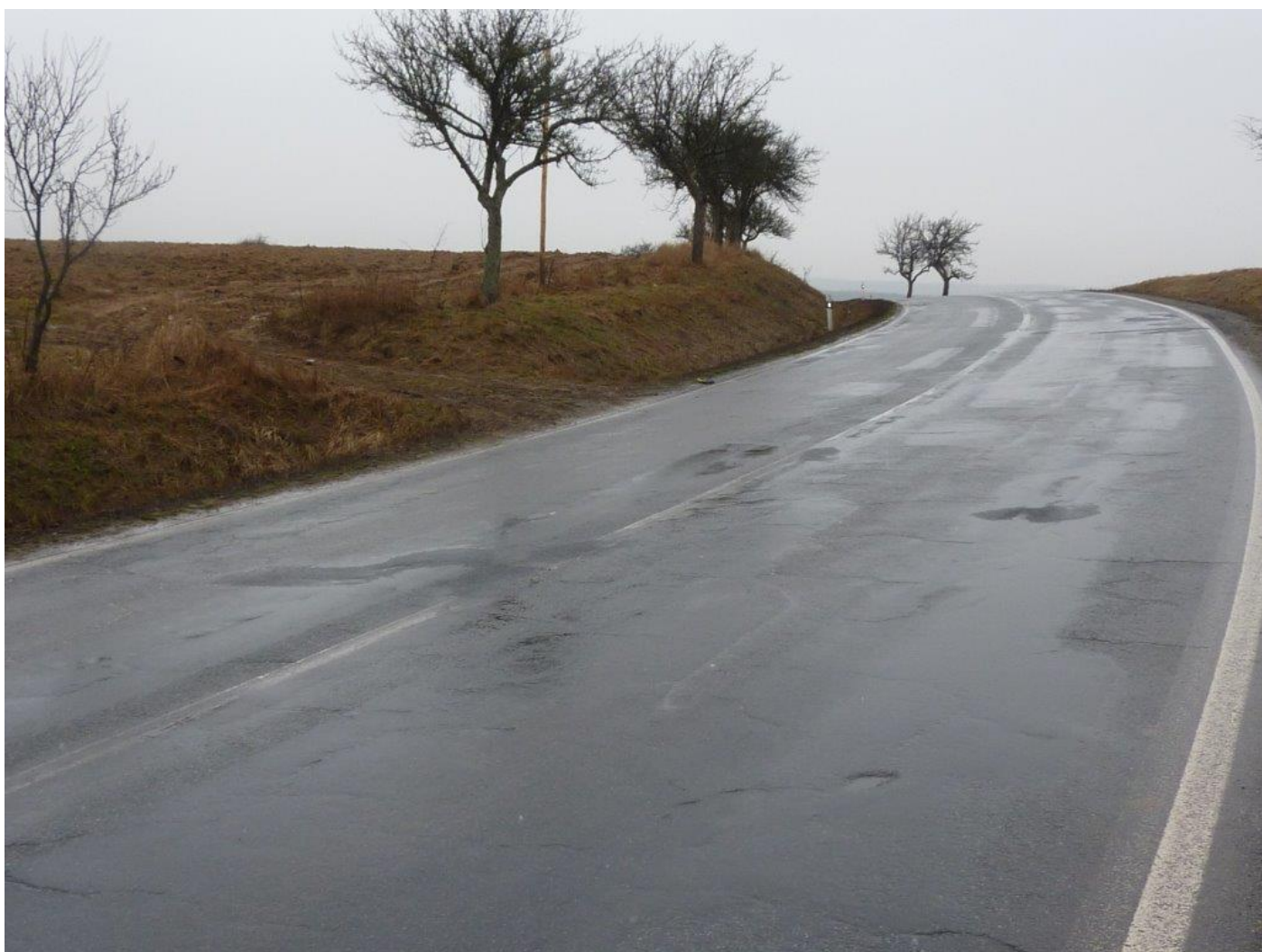
Stávající stav silnice řešené projektem
