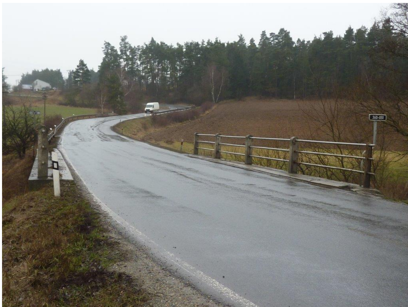
Stávající stav -most
