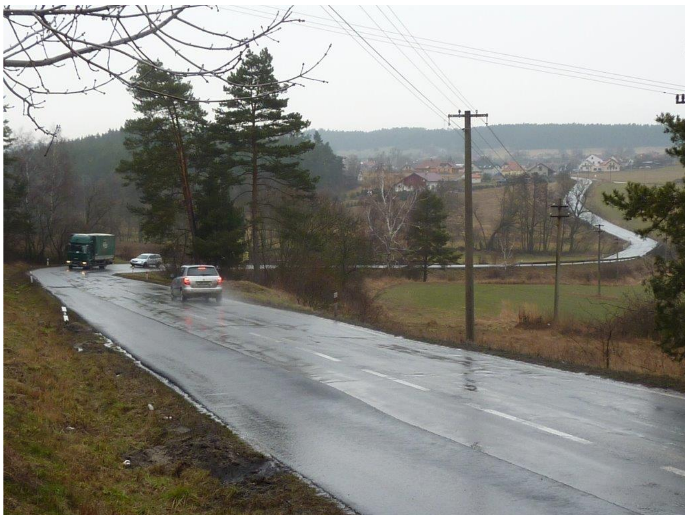
Stávající stav silnice řešené projektem
