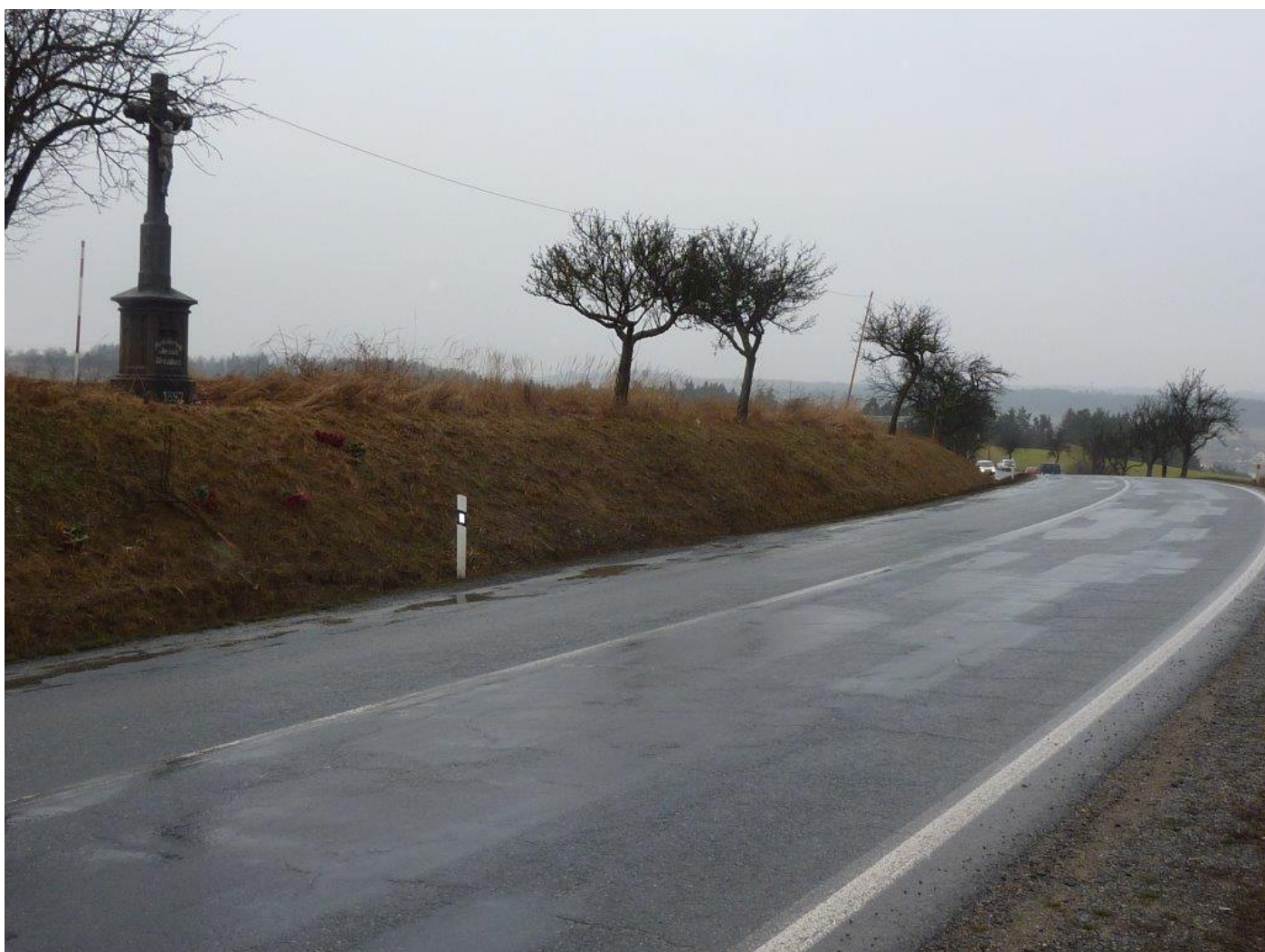
Stávající stav - p emis ovaný k íž
