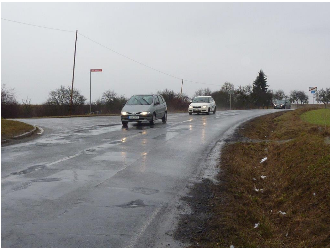
Stávající stav - u ulice Man. Curierových
