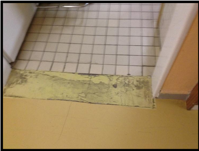
PŘECHOD LITÉ PODLAHY A DLAŽBY
