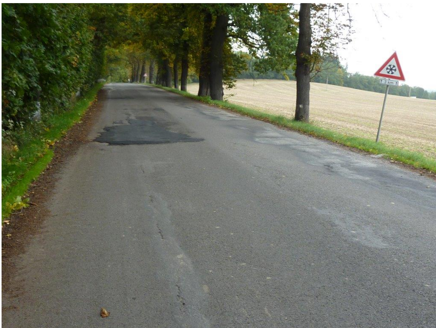
Stávající stav silnice II/345 - úsek 6
