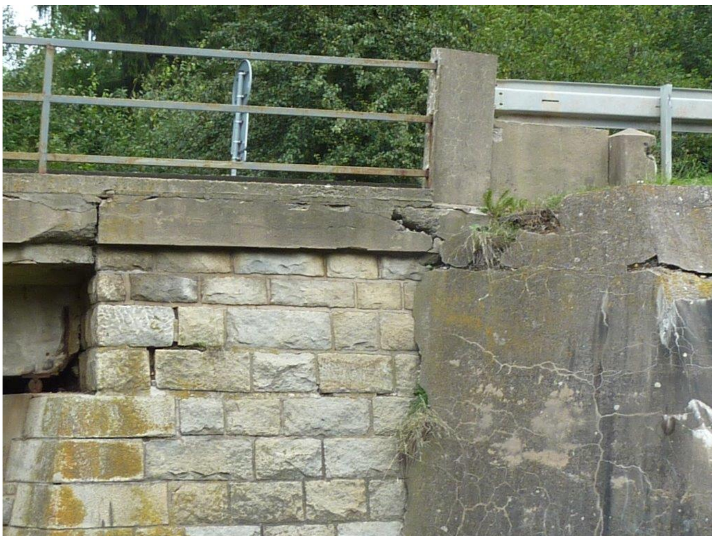
Stávající stav mostu ev. . 345-003
