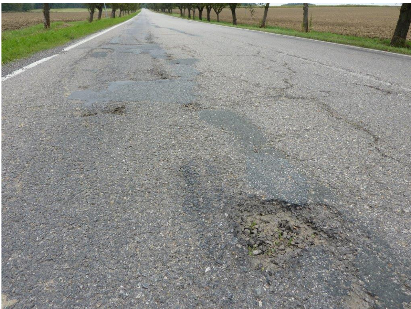
Stávající stav silnice II/345 - úsek 4
