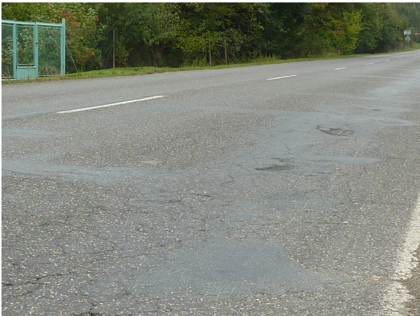
Stávající stav silnice II/345 - úsek 2.1
