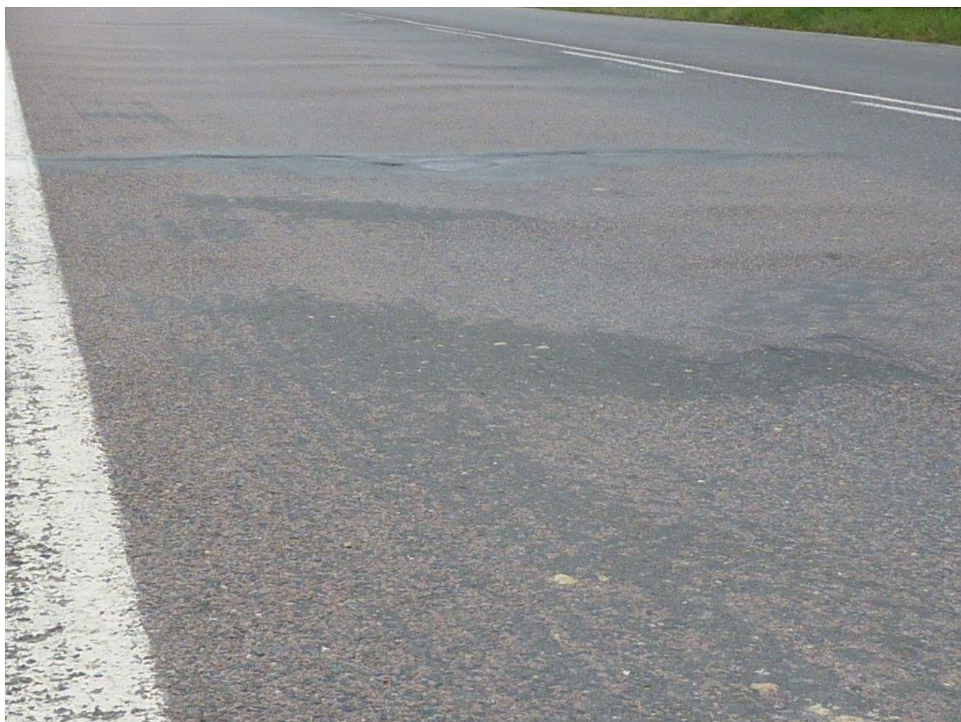
Stávající stav silnice II/345 - úsek 1
