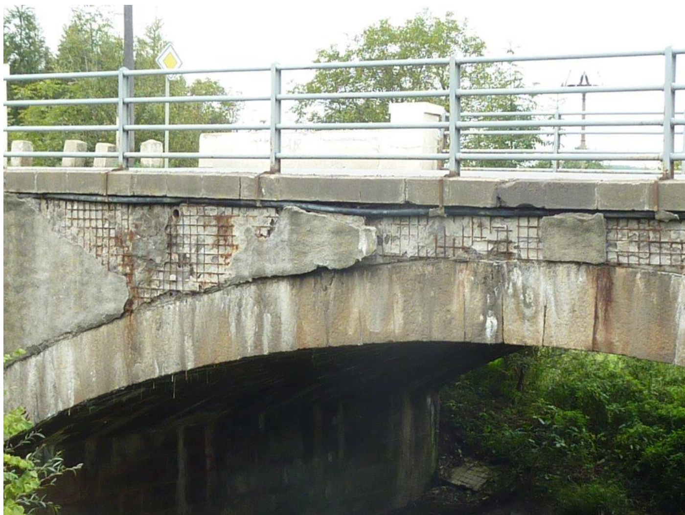
Stávající stav mostu ev. . 345-002
