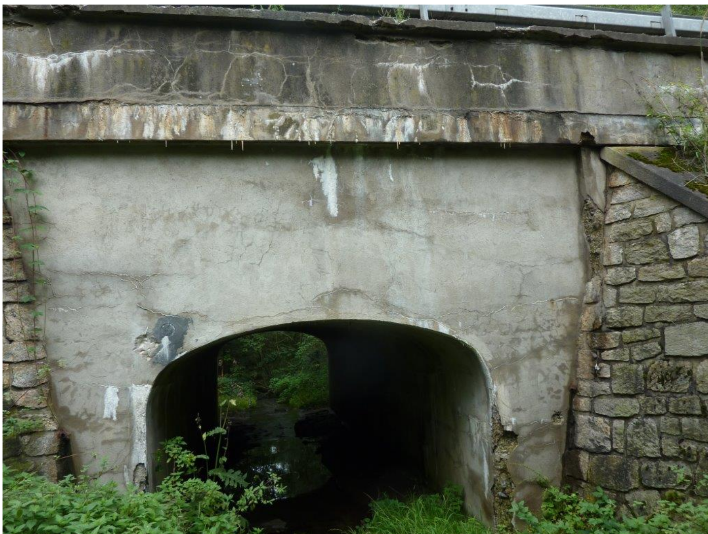
Stávající stav mostu ev. . 345-001
