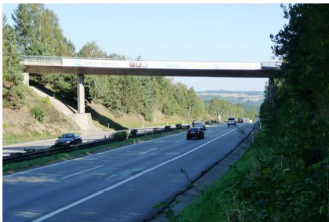
Pohled na most ev. č. 13035-2 od západu ve směru staničení dálnice D1 (18.9.2012)
