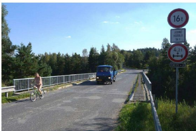
Severní předpolí mostu ev. č. 13035-2 ve směru od Dolních Kralovic (18.9.2012)
