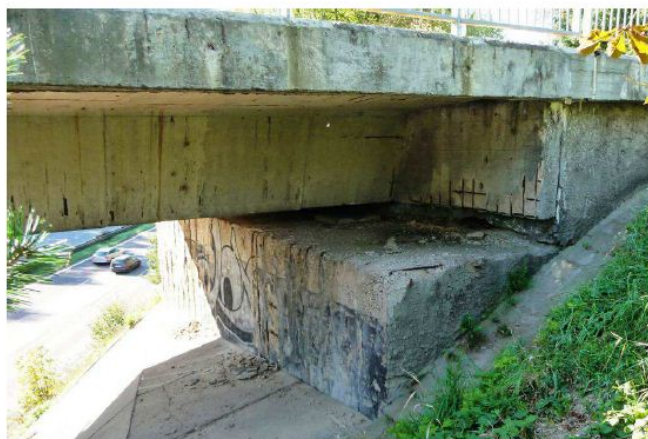
Celkový pohled na severní opěru mostu ev. č. 13035-2 (18.9.2012)
