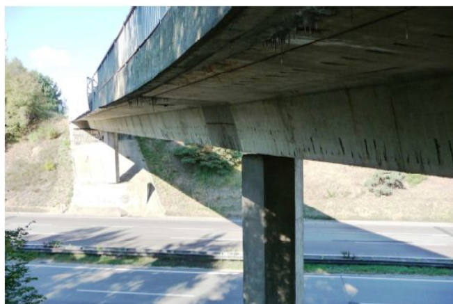
Podhled mostu ev. č. 13035-2 ve směru od jižní opěry (18.9.2012)
