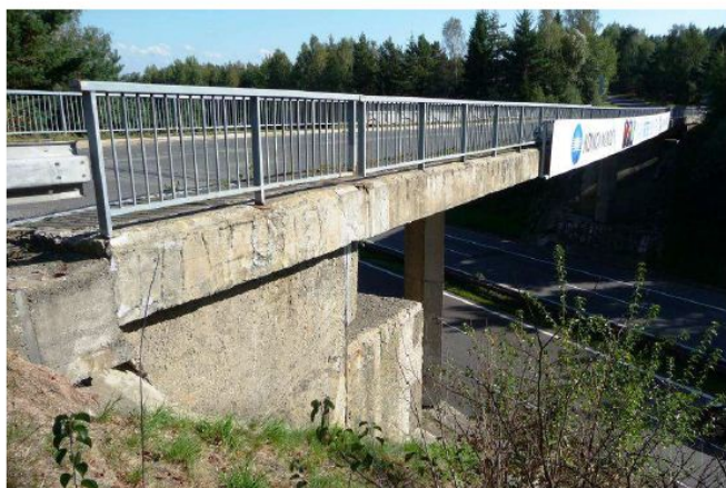
Pohled na severní opěru mostu ev. č. 13035-2 ve směru staničení dálnice D1 (18.9.2012)
