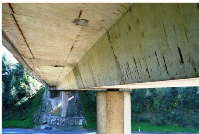
Podhled mostu ev. č. 13035-2 ve směru od severní opěry (18.9.2012)
