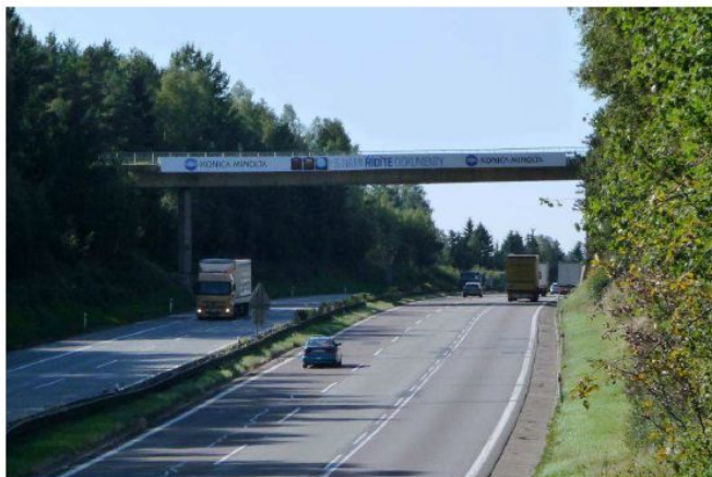
Pohled na most ev. č. 13035-2 od východu proti směru staničení dálnice D1 (18.9.2012)
