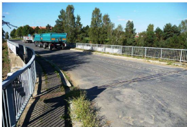
Detail jižního předpolí mostu ev. č. 13035-2 ve směru od Senožat (18.9.2012)
