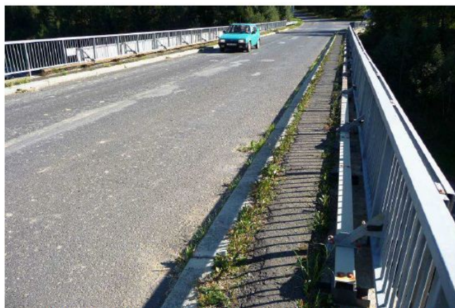
Detail vozovky mostu ev. č. 13035-2 ve směru od Dolních Kralovic (18.9.2012)
