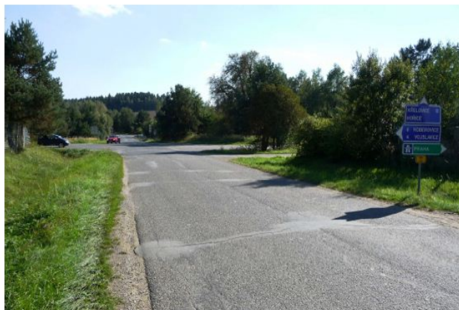
Severní předmostí mostu ev. č. 13035-2 ve směru od Dolních Kralovic (18.9.2012)
