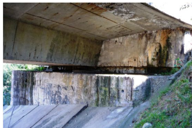
Celkový pohled na jižní opěru mostu ev. č. 13035-2 (18.9.2012)
