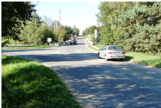
Jižní předmostí mostu ev. č. 13035-2 ve směru od Senožat (18.9.2012)
