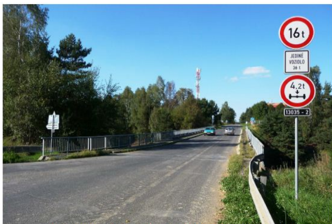
Jižní předpolí mostu ev. č. 13035-2 ve směru od Senožat (18.9.2012)
