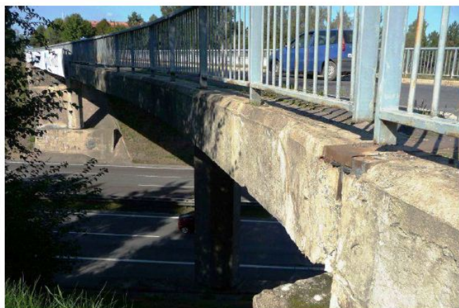
Pohled na jižní opěru mostu ev. č. 13035-2 ve směru staničení dálnice D1 (18.9.2012)
