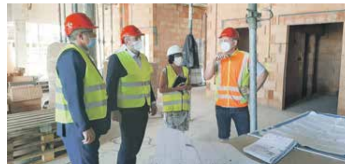
Pravidelná kontrola na stavbě. Vše jde podle plánu. FOTO: JITKA MACOVÁ
