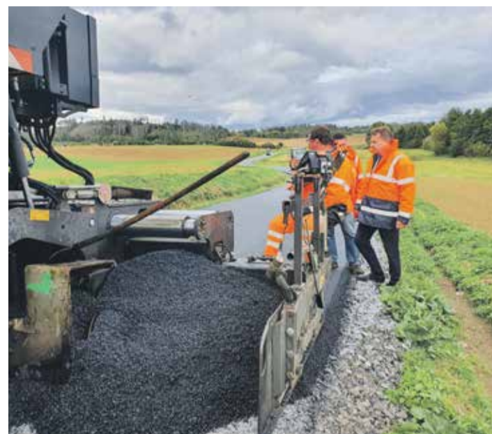
■ Krajští cestáři se starají o krajské silnice II. a III. třídy, provádějí zimní i běžnou údržbu a řeší drobné opravy, rekonstrukce mostů i větší dopravní investice.
