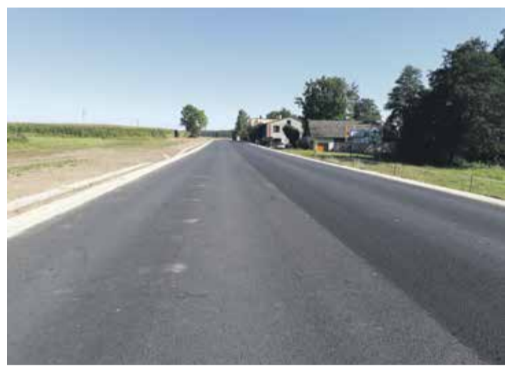
■ Modernizací letos prochází další úsek krajské páteřní silnice II/602 z Jihlavy na Pelhřimov. Část u Hubenova má být otevřená se závěrem října.
