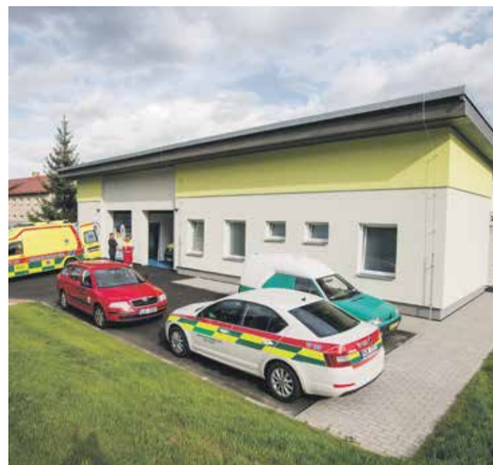
■ Nové výjezdové stanoviště ZKS Kraje Vysočina v Ledčí nad Sázavou.
