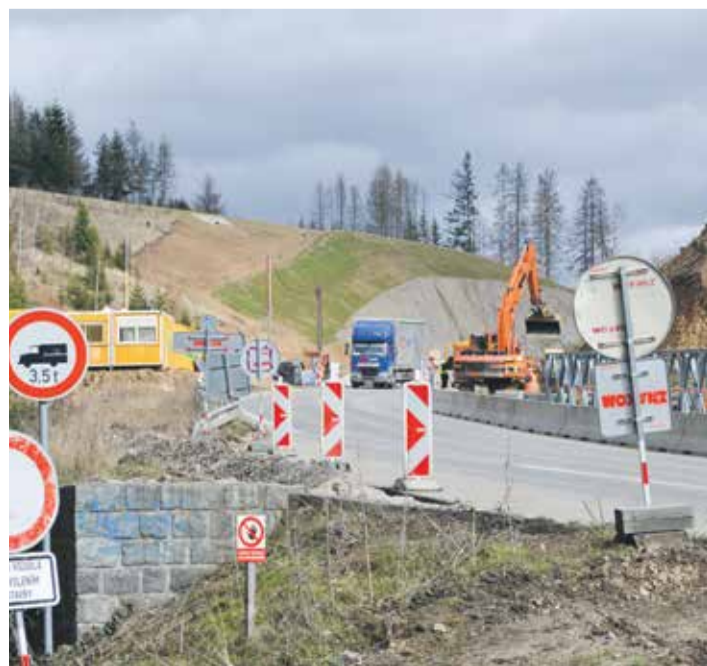
■ Stavba obchvatu II/602 Velkého Beranova.
