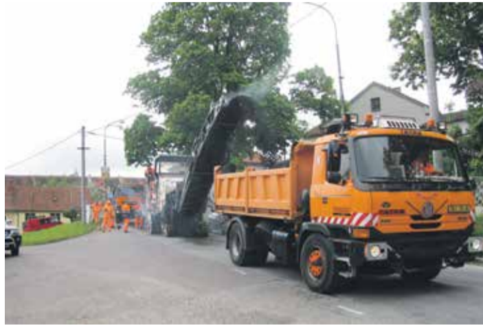
■ V zimě udržují, po zbytek roku mimo jiné opravují výtlučky na silnicích.
