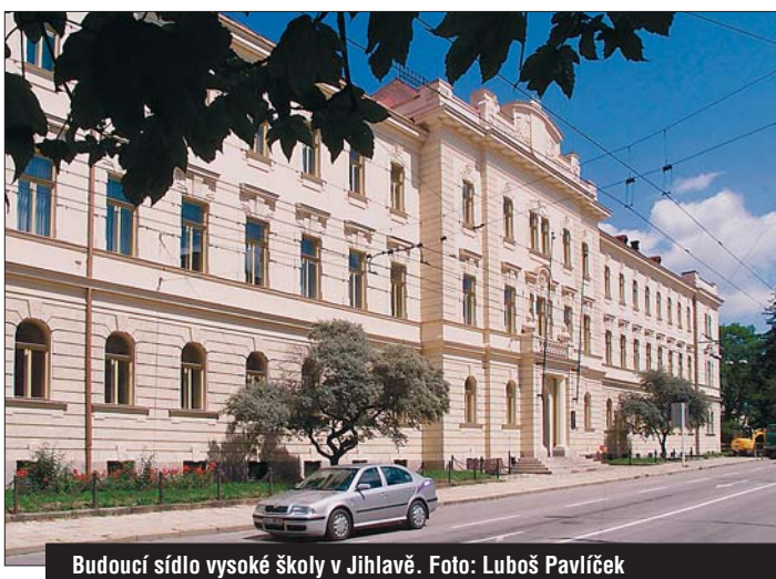
Budoucí sídlo vysoké školy v Jihlavě. Foto: Luboš Pavlíček
