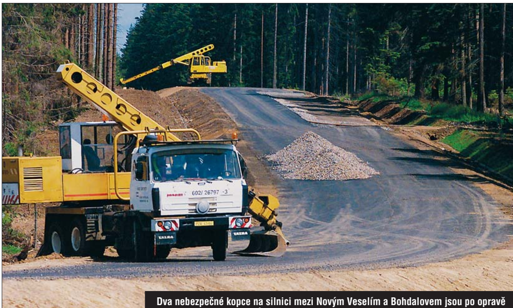
Dva nebezpečné kopce na silnici mezi Novým Veselím a Bohdalovem jsou po opravě nižší o devět a šest metrů. Foto: Luboš Pavlíček
