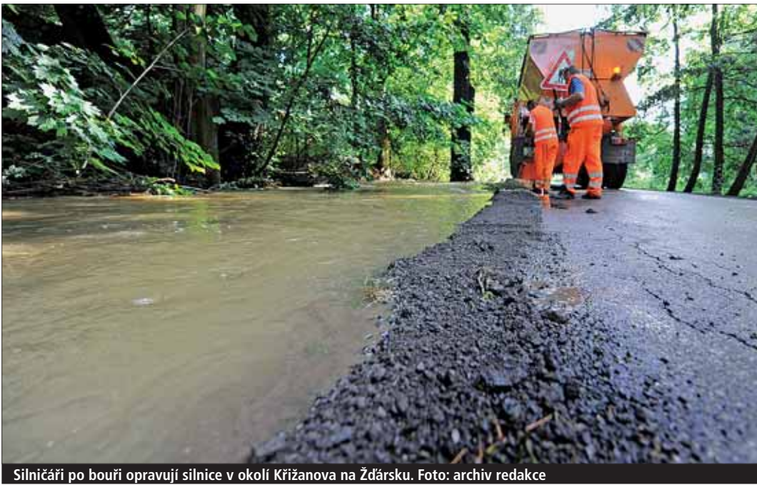
Silničáři po bouři opravují silnice v okolí Křižanova na Žďársku. Foto: archiv redakce
