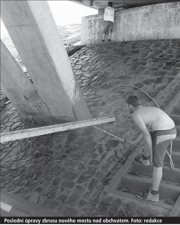
Poslední úpravy zbrusu nového mostu nad obchvatem. Foto: redakce
