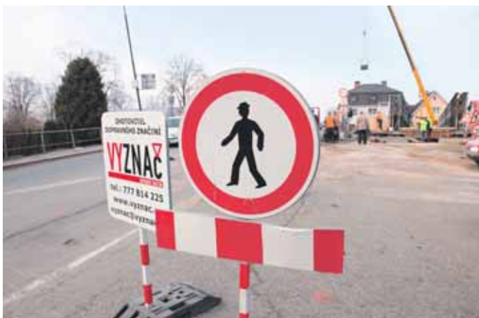
Jednou ze staveb, které byly zahájeny na konci zimy, je také rekonstrukce mostu přes železniční trať v Okrouhlicí na Havlíčkovobrodsku.
