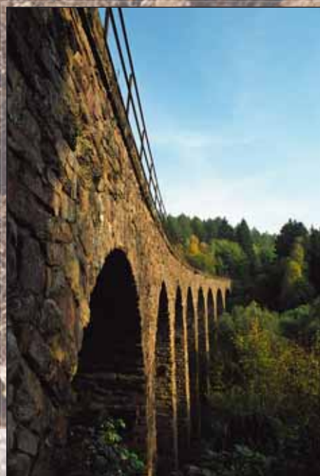
Viadukt u Nové Vsi
